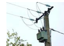
Transformateur de quartier
