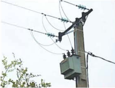
Transformateur de quartier
