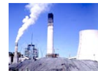
Centrale électr. à charbon
