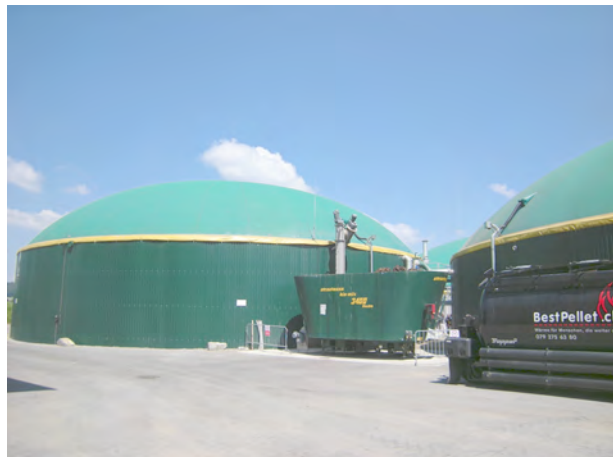
Les dômes abritant les cuves de fermentation
