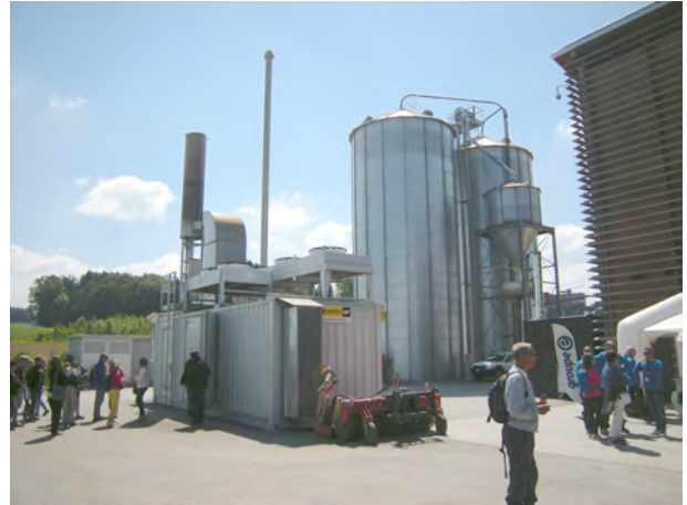
Au premier plan, l'installation de cogénération, en arrière les silos de stockage des pellets
