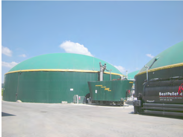
Les dômes abritant les cuves de fermentation
