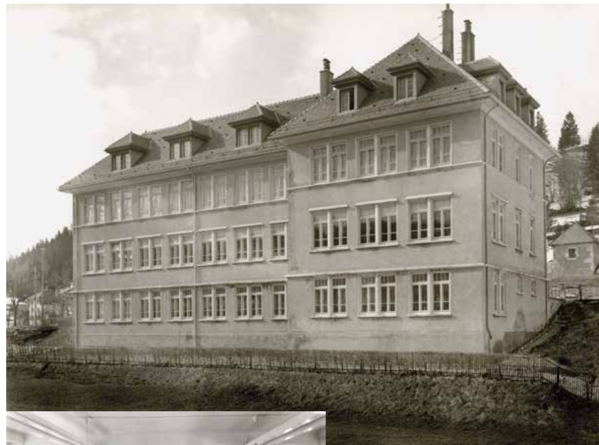
Ill. 7 Usine de l'Essor, 1928.
