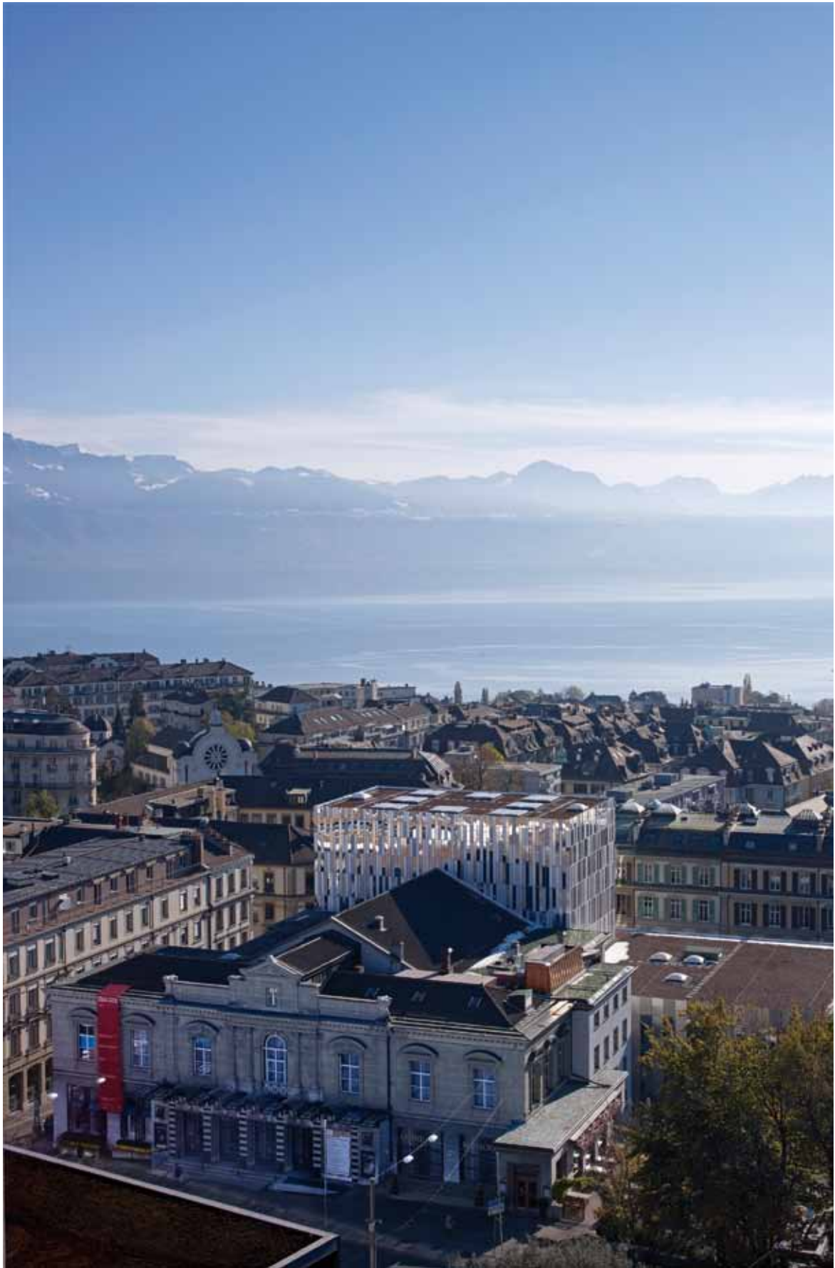
Les travaux se sont achevés en septembre 2012.
