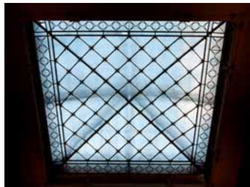
Verrière à la ferronnerie travaillée.
