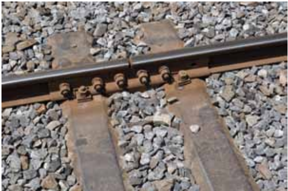
Les éclisses des rails = jointures
